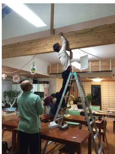
(a) ビーコン受信機設置作業
